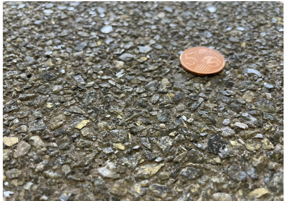
Glattgeschalter Sichtbeton der Rezeptur zum Vergleich. Smooth, form-finished surface of this mix design to compare.
